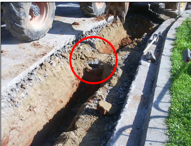
Vista de l'estructura per enllumenat públic u.e.0, encerclada en vermell
