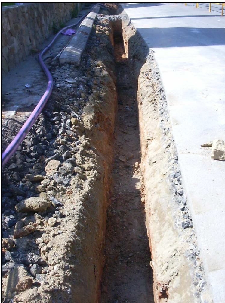
Vista final dels rebaixos de la rasa
