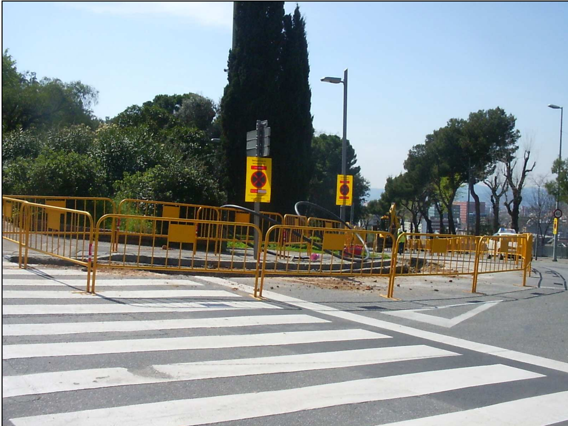
Vista final del tram est de la rasa un cop rebaixat
